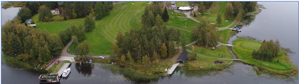
Kuva 4. Alueen pohjoisosassa länsirannalla on Järviseudun Golfseuran klubirakennus sekä itärannalla kolme lomarakennusta piharakennuksineen. Niemen pohjoiskärjen rakennelmia ovat grillikota sekä venesuoja sekä venelaituri. © Plandea
