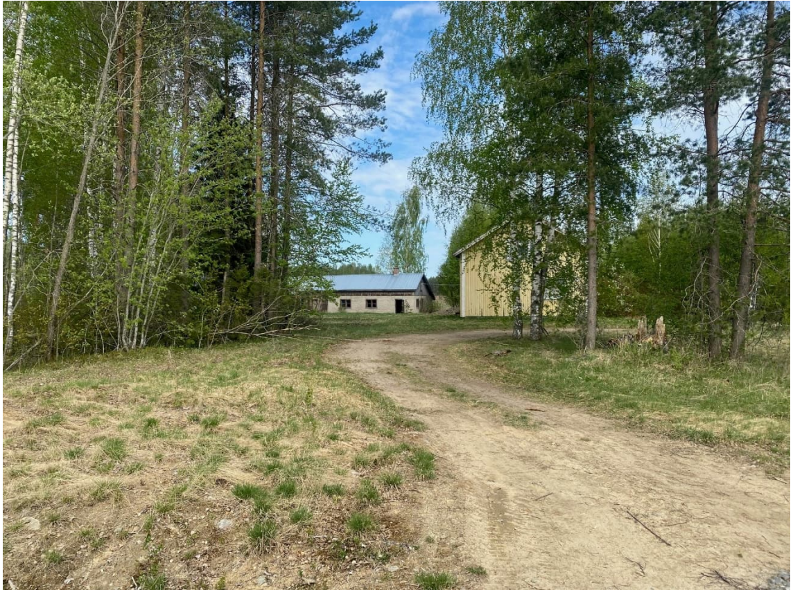
Kuva 2a. Asumattoman omakotitalon pihaa asfaltoidun katuosuuden lopusta kuvattuna.
