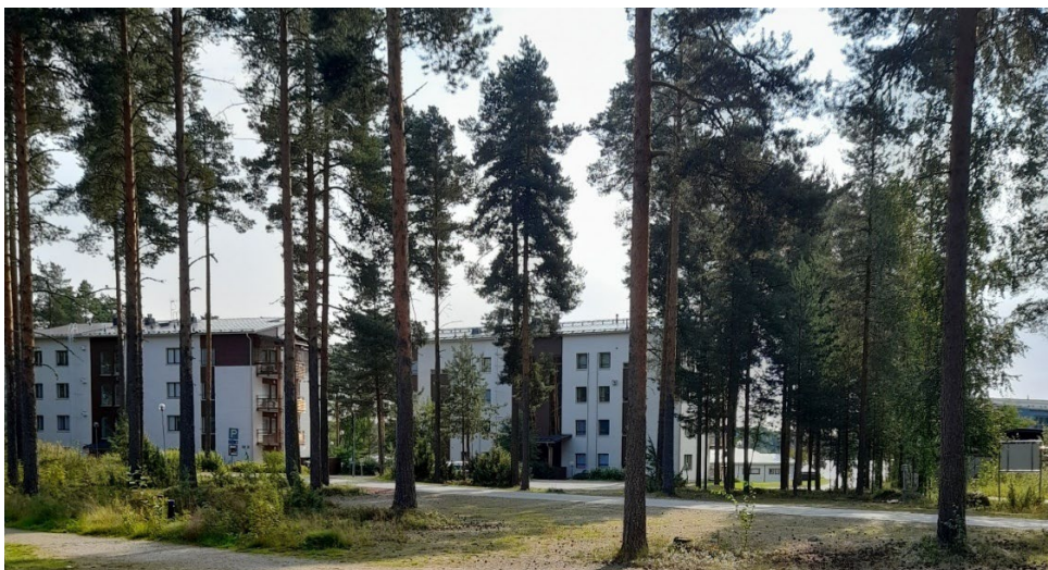
Kuva 4. Kivitipun takana on 5-kerroksisia kerrostaloja.
